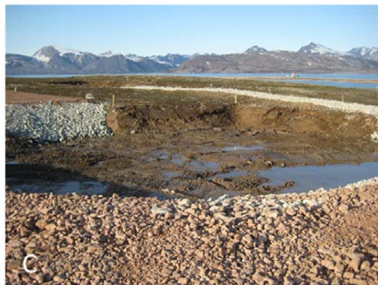
Figur 3.1. Brøytet veitrase (A) og ferdigstilt vei ned til stasjonsområdet ved Brandallaguna (B). De neste bildene er fra anleggsarbeid på stasjonsområdet og viser uttrauing ned til permafrost for VLBI1-fundamentet (C), uttrauing ned til permafrost for SLR-fundamentet (D) og starten på utgraving for VLBI2-fundamentet. Bilde A ble tatt i juni, bilde B, C og D ble tatt i august, og bilde E ble tatt i starten av oktober 2014. Foto: Maarten Loonen (A) og Torbjørn Nørbech (B-E).
